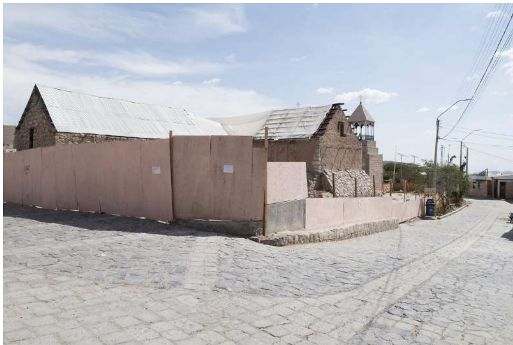
Imagen 7. Vista hacia el muro testero desde la calle del pueblo.
