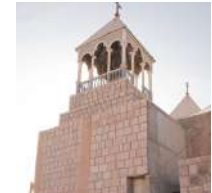
Envolvente de piedra de refuerzo del torreón.
