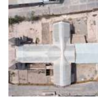
Transformación de la calle Tarapacá en acceso vehicular, transformando el templo en una especie de rotonda. La conexión con el pueblo y algunos actos quedan desplazados..
