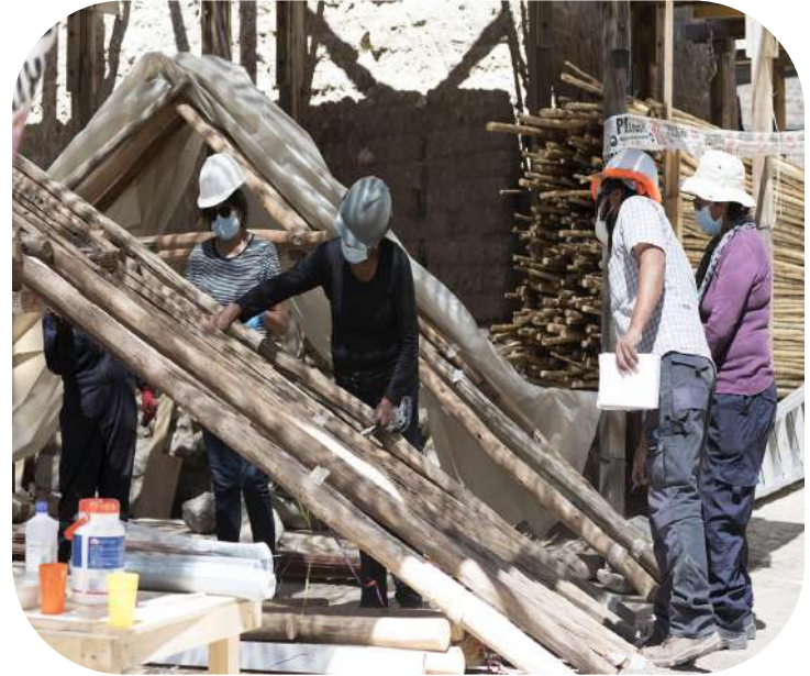
Imágenes construcción de techumbre tradicional Templo San Santiago de Belén
