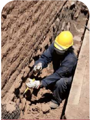
Consolidación de fundaciones y sobrecimientos mediante calzaduras, inyección de morteros y emboquillados de cal y arena. Templo San Pedro de Atacama 2014
