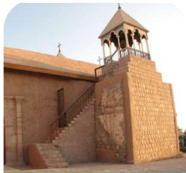
Restauración escalera acceso campanarios
