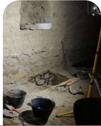
Pozos de sondeo para revisar estado de fundaciones e implementar el plan de manejo arqueológico. Templo de Belén 2021
