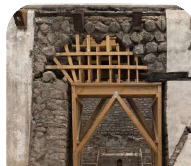
Consolidación de arcos
