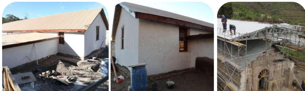
Restauración de la cubierta con planchas de calamina - Templo de Belén
