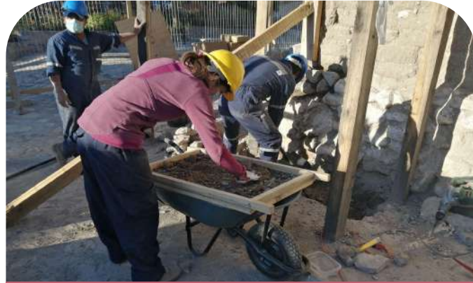
Pozos de sondeo para revisar estado de fundaciones e implementar el plan de manejo arqueológico. Templo de Belén 2021
