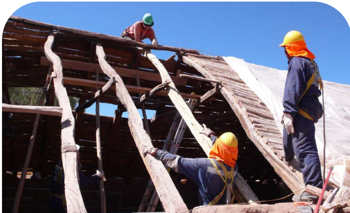
Consolidación y reestructuración estructura de techumbre
