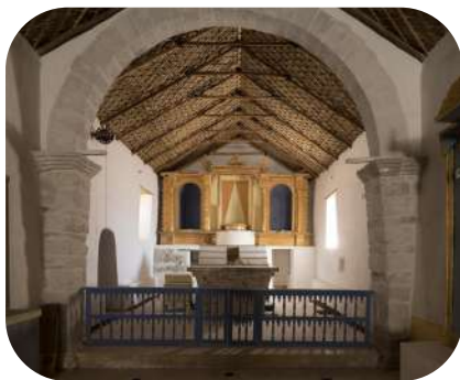
Foto interior Pares y nudillos Templo San Santiago de Belén
