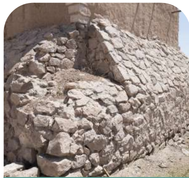
Consolidación de contrafuertes
