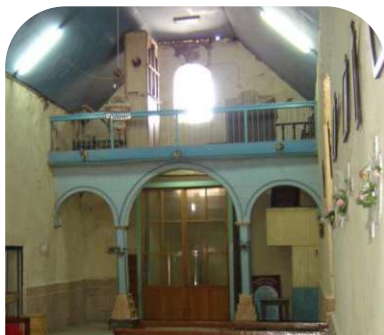
Reconstrucción arcos de acceso/ soporte coro
