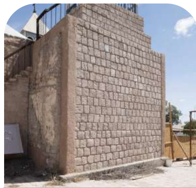
Restauración primer cuerpo torres
