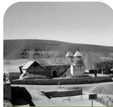
Restauración muro perimetral
