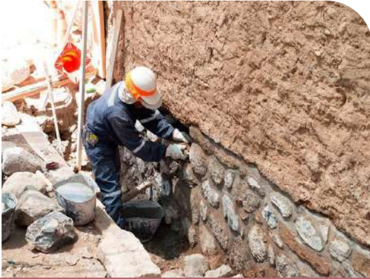
Consolidación de fundaciones y sobrecimientos mediante calzaduras, inyección de morteros y emboquillados de cal y arena. Templo San Pedro de Atacama 2014
