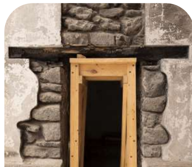
Reconstrucción de vanos Reintegración de dinteles calcinados
