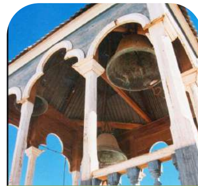
Restauración cubierta torres
