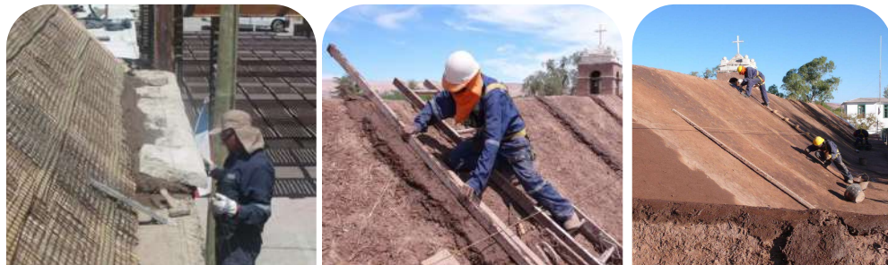
Restauración de la cubierta con planchas de calamina
