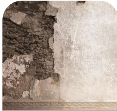
Consolidación de muros interiores y exteriores
