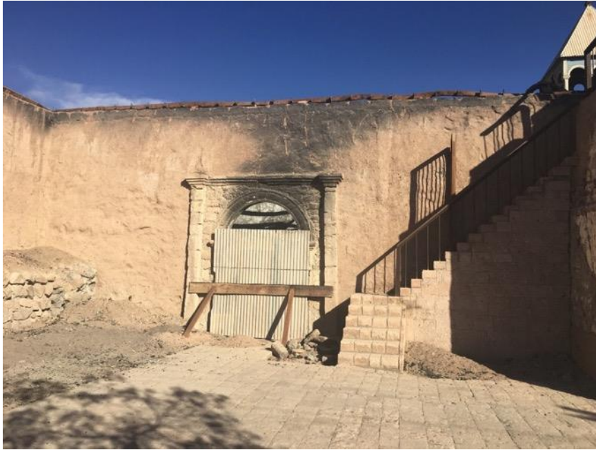
Imagen: Muro del evangelio, acceso lateral
