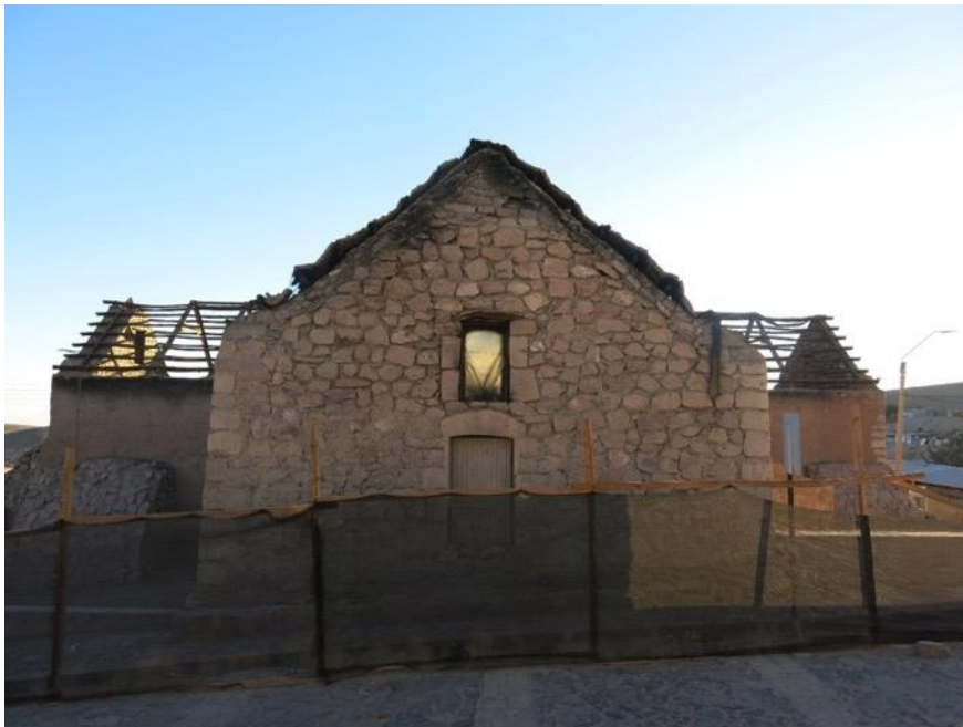
Imagen: Muro testero
