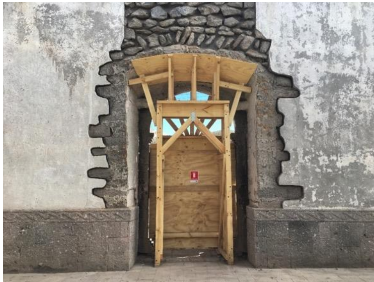
Apuntalamientos de emergencia
