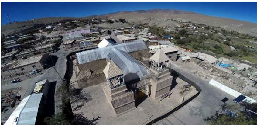
Retiro de techumbre colapsada e instalación de protección en cubierta
