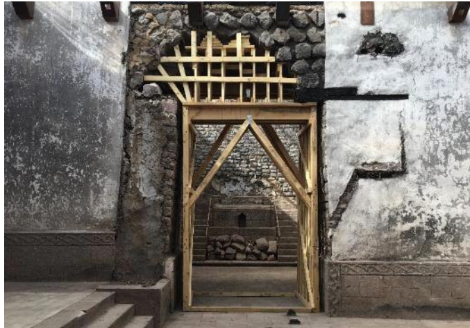
Instalación de apuntalamientos en vanos
